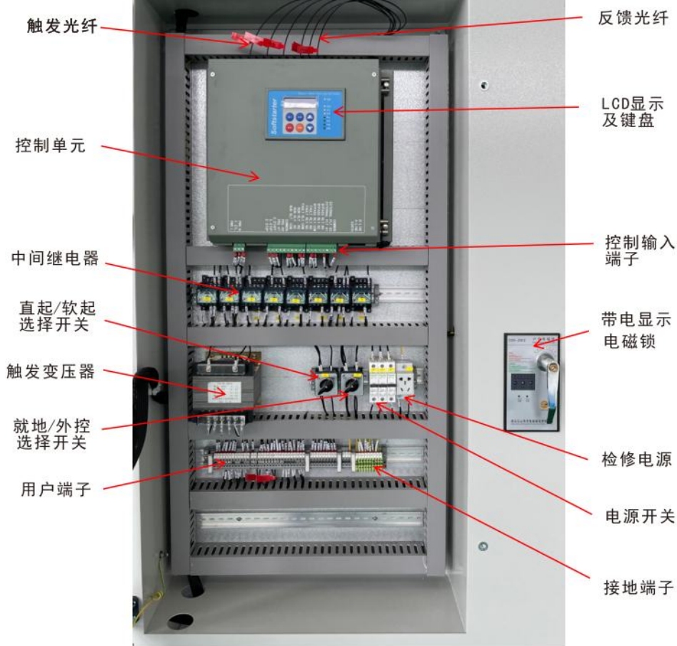
图五、MDMVS中高压固态软起动低压舱室
